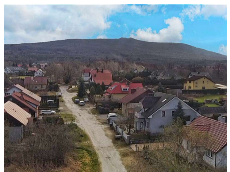
Wkrótce ruszą roboty drogowe na ul. Kwiatowej i ul. Łąkowej w Sobótce
