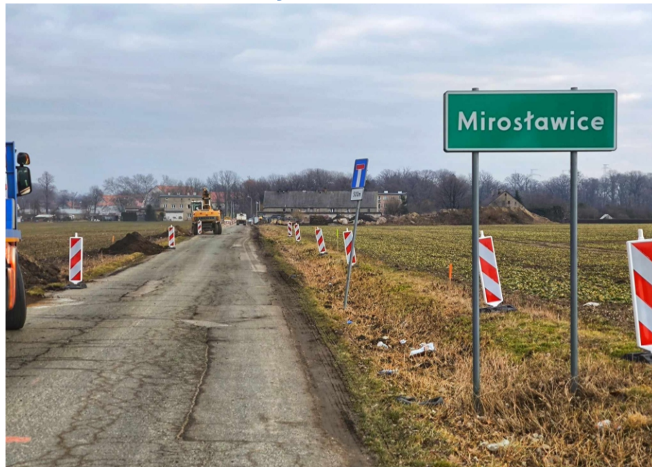
■ Wykonanie podbudowy pod nowy chodnik
