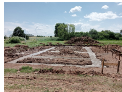
■ Fundamenty pod świetlicę w Okulicach
