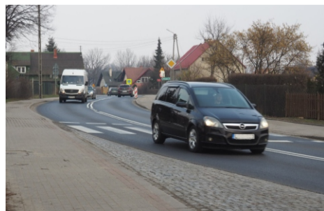
FOT. Droga nr 35 w Mirosławicach. Mieszkańcy mają nadzieję, że ronda spowolni ruch
